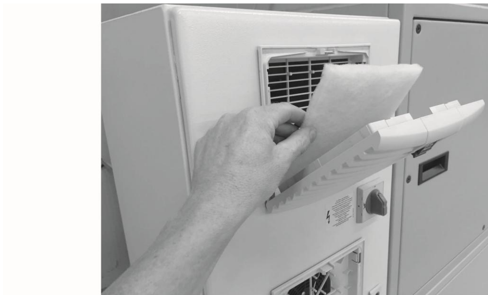
Рис. 39: Замена фильтра распределительного шкафа
